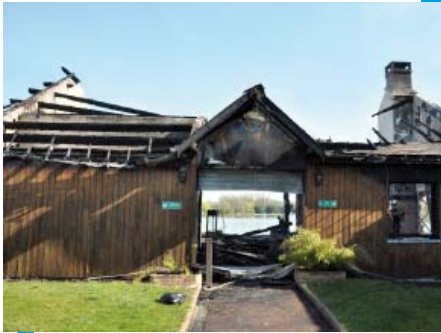
l'entrée du restaurant après l'incendie
