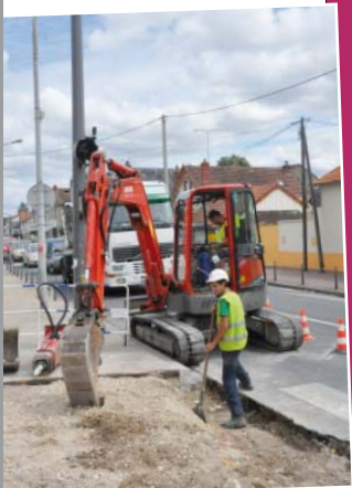
Travaux d'été P 4
