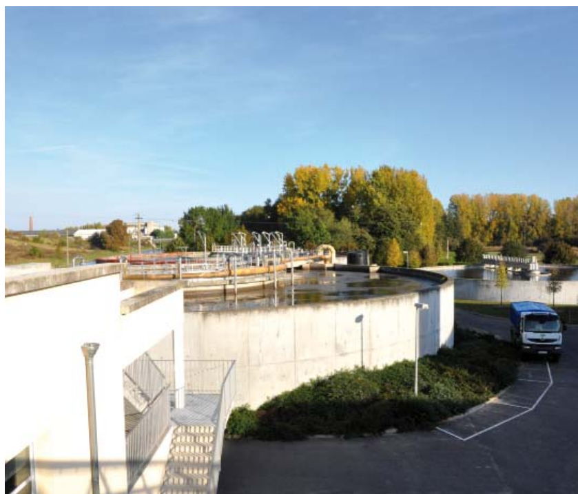
La station d'épuration des Prés-blonds.
