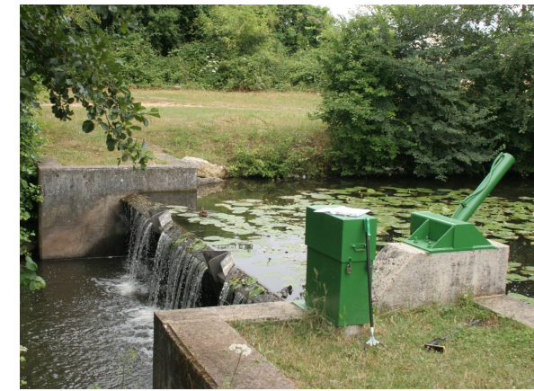
Le Barrage de Montalibert à Châlette-sur-Loing
